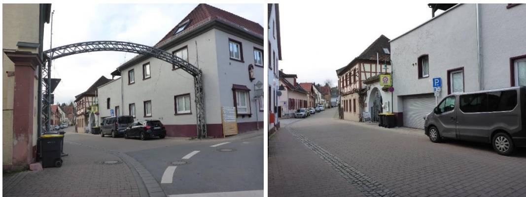
Abbildung 4: Eingangssituation Nord und Abschnitt 1 (nördl. Carl-Zuckmayer-Platz)
