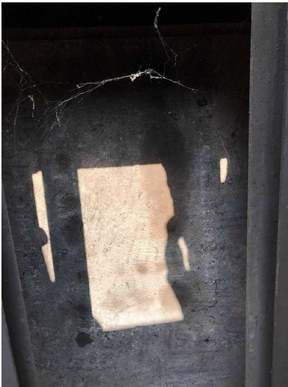
Bild 16: KVF 17, Bodenplatte nach Ausbau des Trafos 'Nord-Ost'
