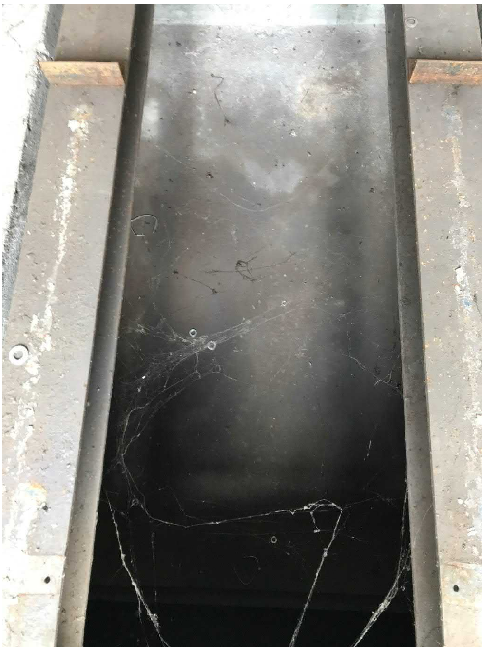
Bild 15: KVF 17, Bodenplatte nach Ausbau des Trafos 'Süd-West'
