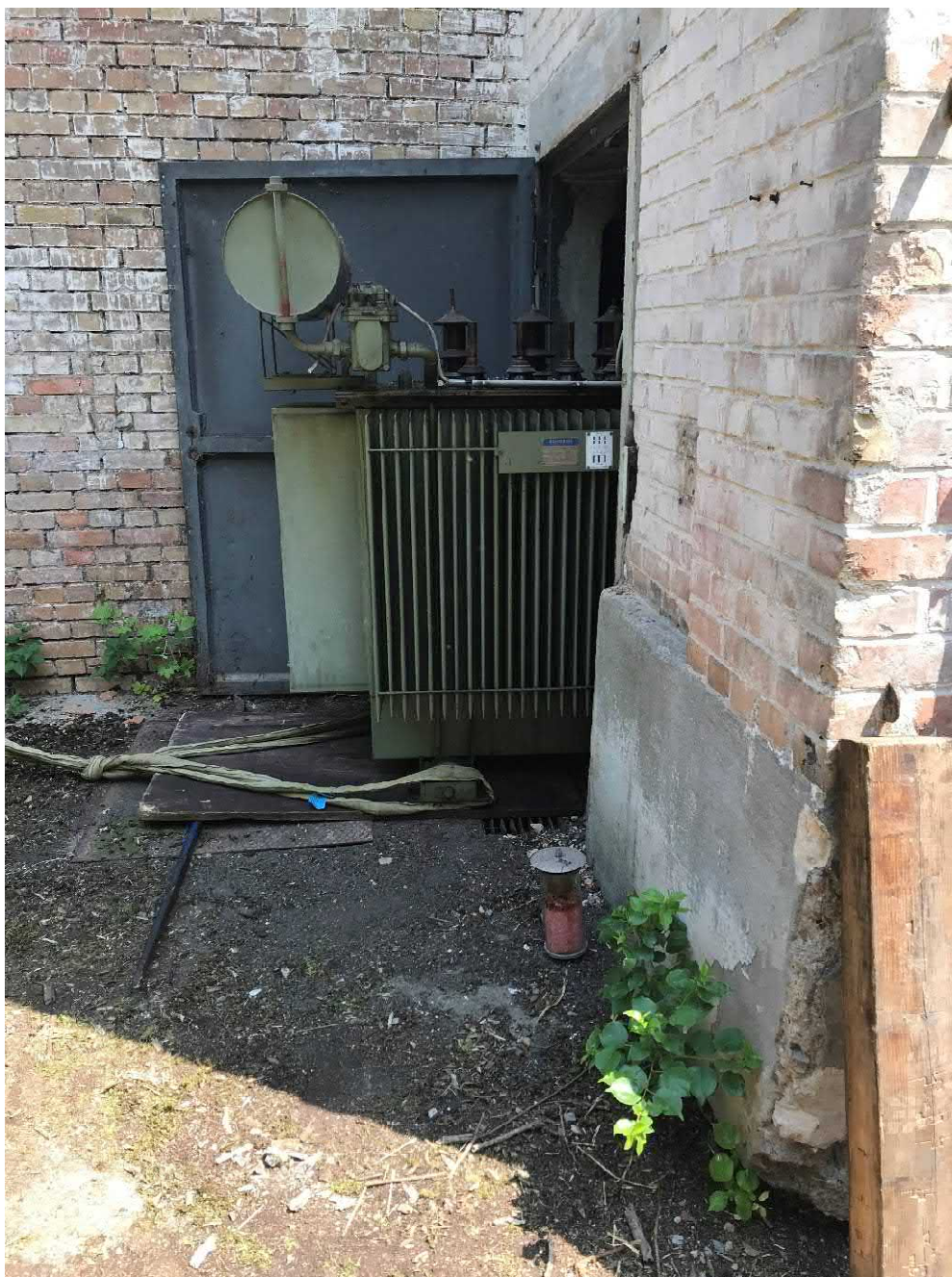
Bild 8: KVF 16, Ausbau der Transformatoren
