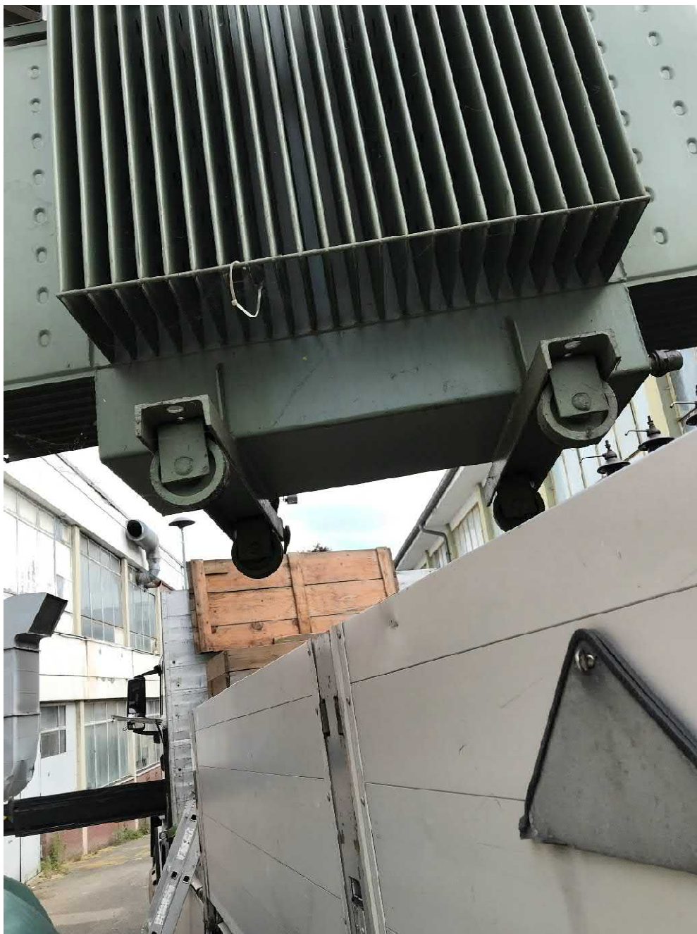
Bild 14: KVF 17, geringe Feuchte an der Unterseite der Transformatoren
