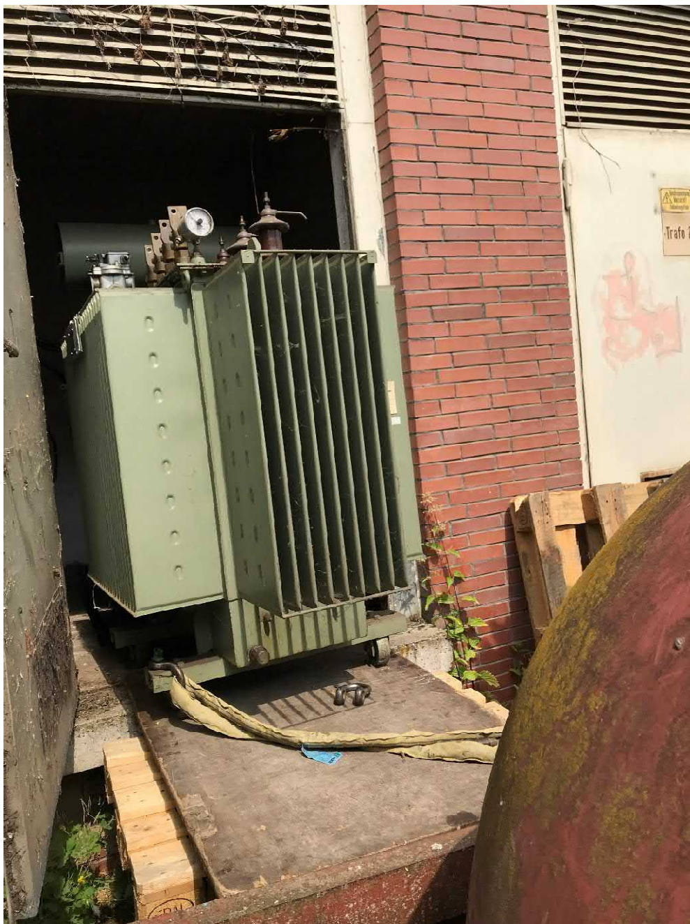
Bild 13: KVF 17, Ausbau der Transformatoren
