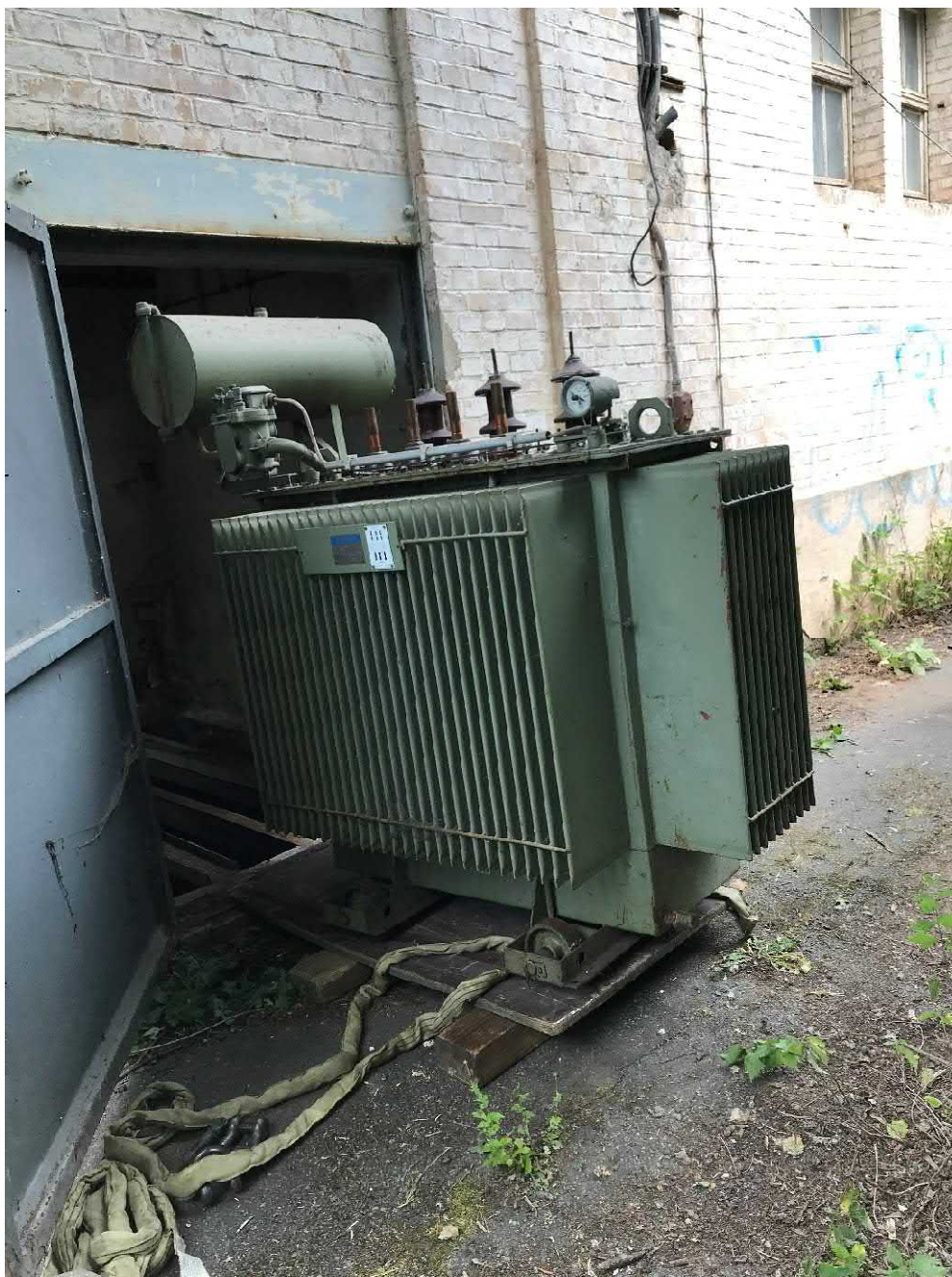
Bild 7: KVF 16, Ausbau der Transformatoren
