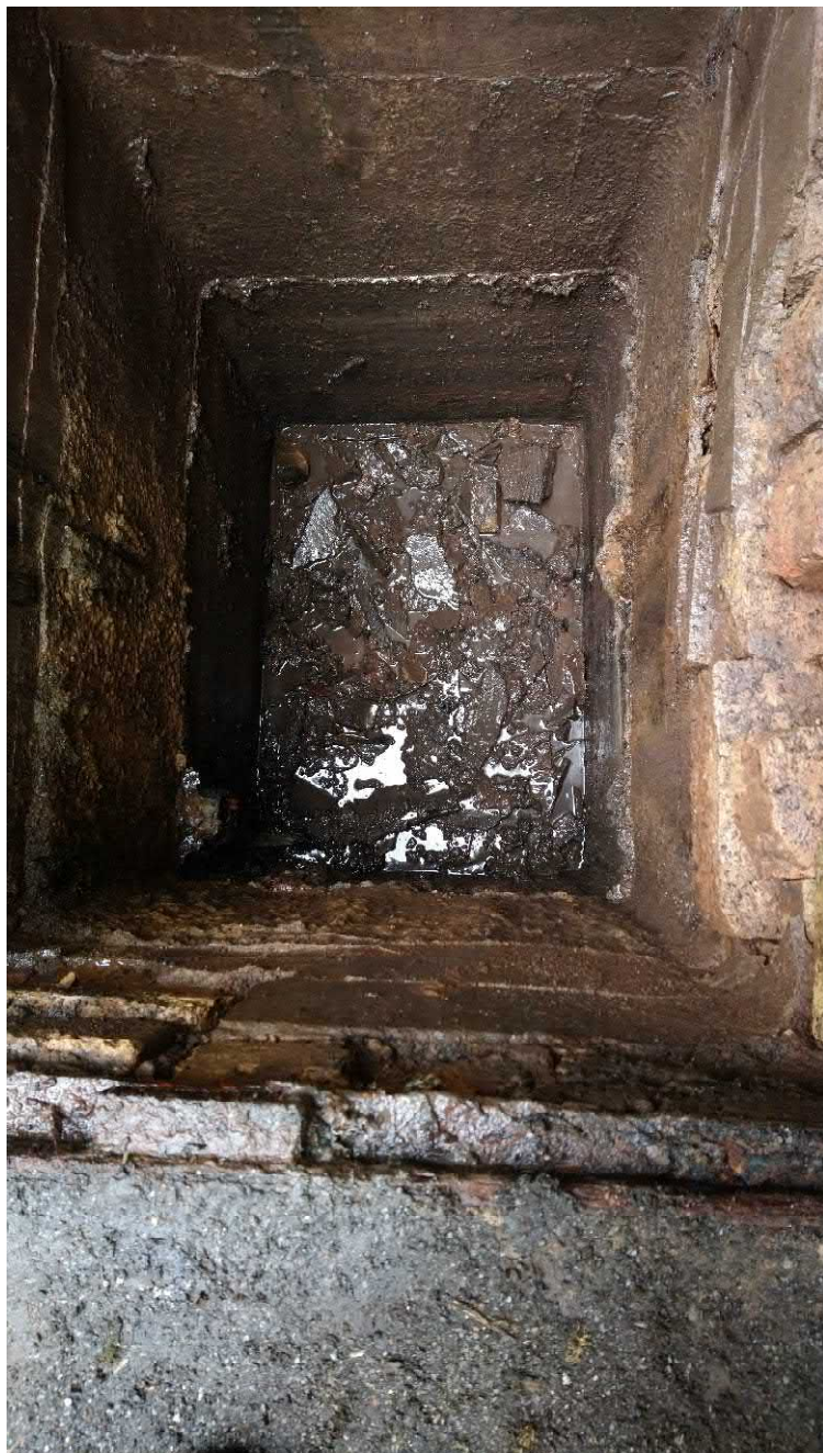
Bild 12: KVF 16, Schacht vor Transformatorenkammer nach Reinigung
