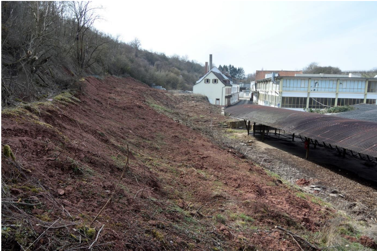
Abbildung 3: Übersicht über das nordöstlichen Gelände der Kapsel­fabrik.
