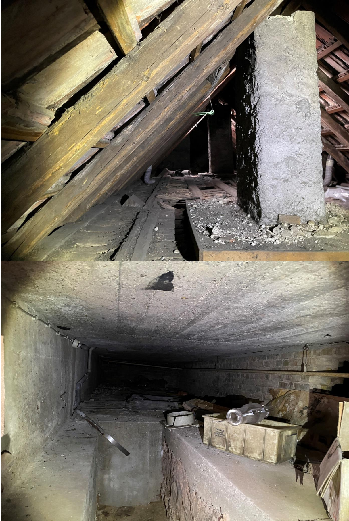
Abbildung 19: Beispiele der Kontrolle der Dachböden (oben) und Keller (unten) auf Fledermausbesatz.
