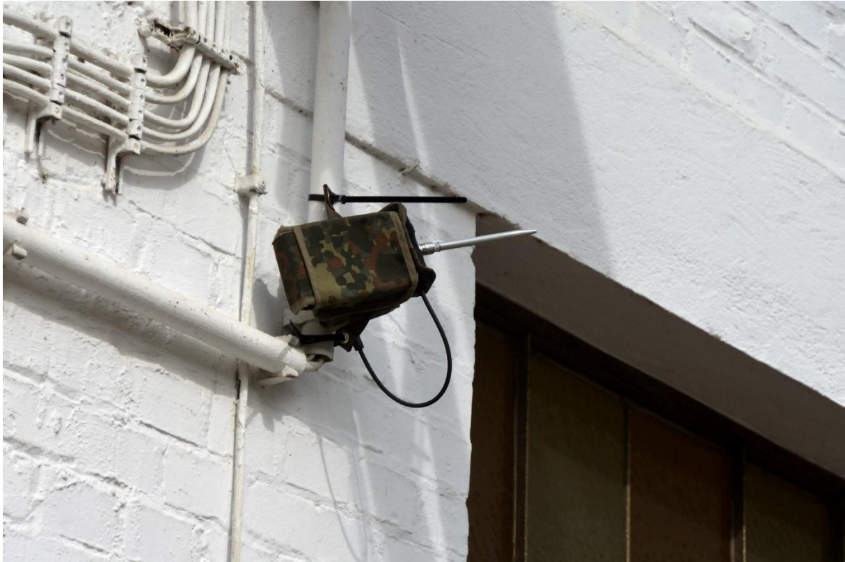
Abbildung 13: BatCorder, der den Korridor zwischen den Gebäuden detektiert.
