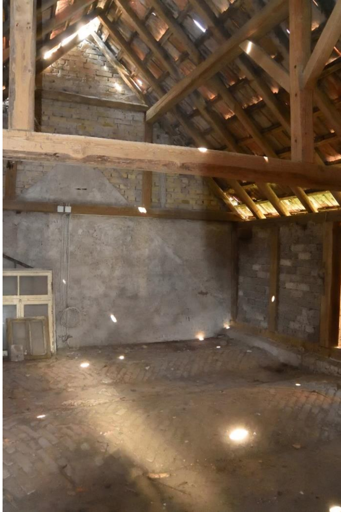
Abbildung 36: Dachboden von Gebäude 3 und 4.
