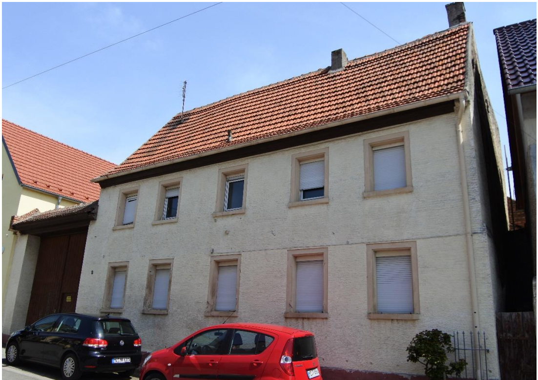
Abbildung 22: Gebäude Königstuhlstraße 2, hier sind potentielle Habitate für Gebäudebrüter, wie Vögel und Fledermäuse, am Haus und im Hof vorhanden (Fotos: BGNatur).
