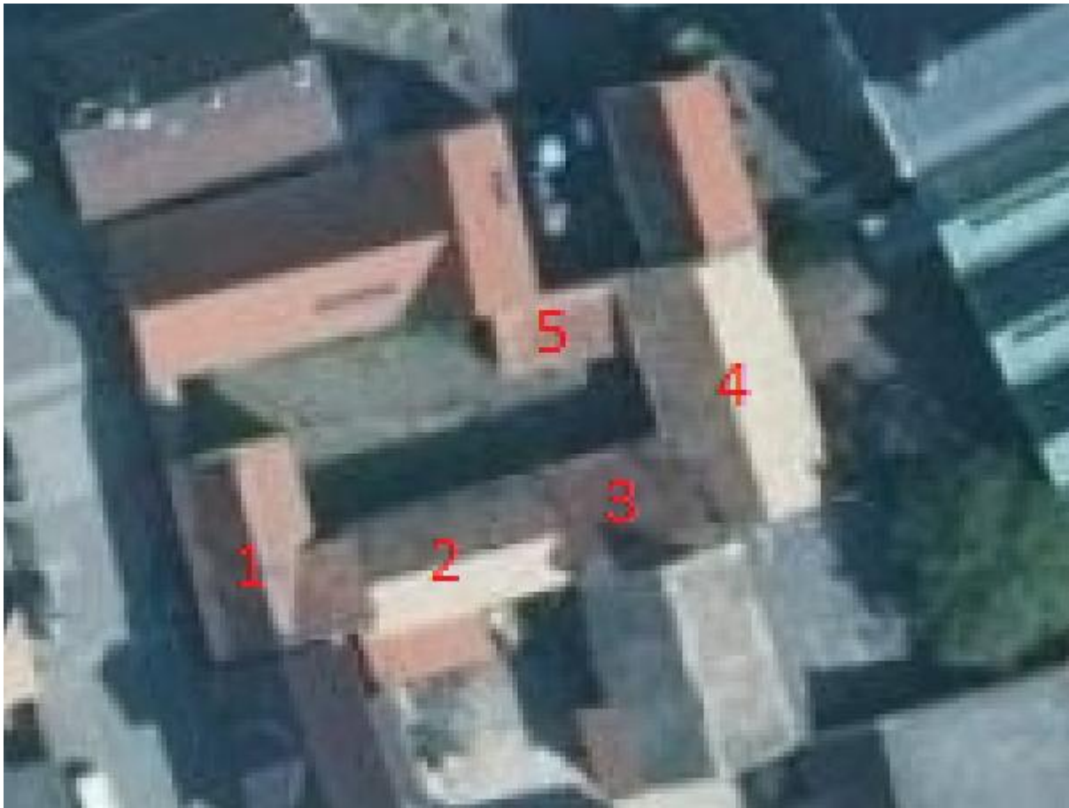
Abbildung 33: Königsstuhlstr. 2, Lörzweiler. Nummerierung der Gebäude: 1 Wohnhaus mit Dachboden, 2 ehem. Viehstall, 3 kleine Scheune mit Dachboden, 4 Große Scheune mit Dachboden und Unterkellerung, 5 kleines Nebengebäude.
