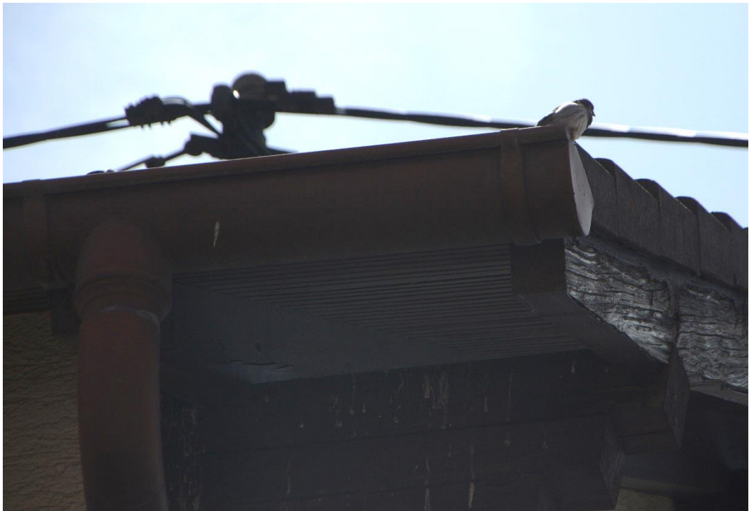
Abbildung 32: Haussperling Passer domesticus auf Gebäude Rheinstraße 17 aus nordöstlicher Richtung; am Balken darunter sind deutlich Kotspuren zu sehen, was auf eine Besiedlung durch Gebäudebrüter hinweist (Fotos: BGNatur).
