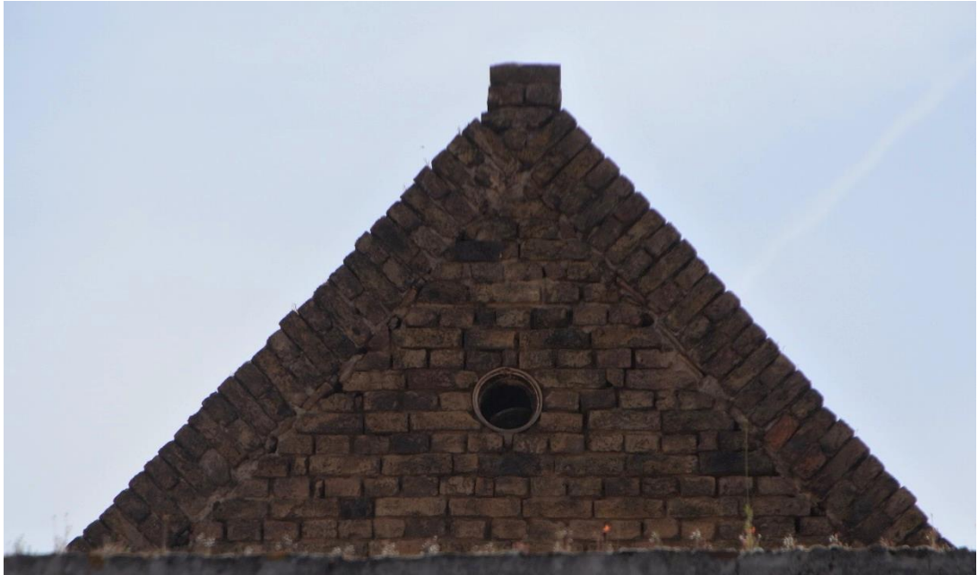
Abbildung 24: In den Hinterhöfen stehen viele ältere Scheunen, die durch die Dachkonstruktion oder Öffnungen potentielle Habitate für Gebäudebrüter, wie Vögel und Fledermäuse, bieten (Fotos: BGNatur).
